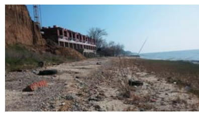
Фото 13. Строительство многоквартирных домов в районе Приморского парка г. Таганрога на момент обследования 13.04.2017 г
