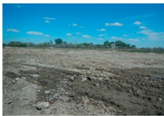
Завершение работ по рекультивации полигона твердых коммунальных отходов в г. Батайске
