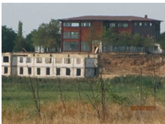
Фото 6. Ведение работ по изменению берега Пролетарского водохр. при строительстве здания ООО «Великокняжеский конный завод»
