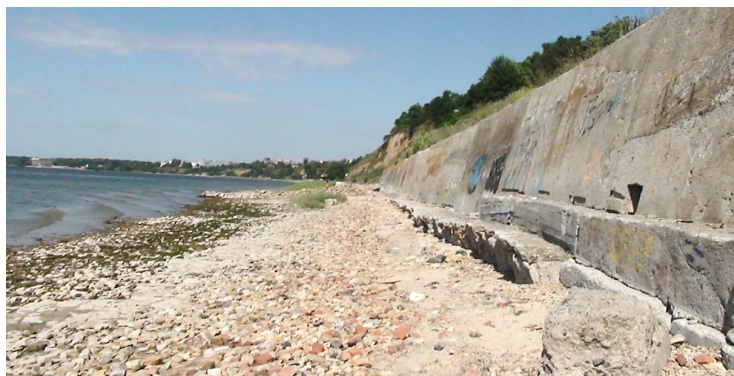
Рис. 45. Берегоукрепительное сооружение (детская многопрофильная больница).
