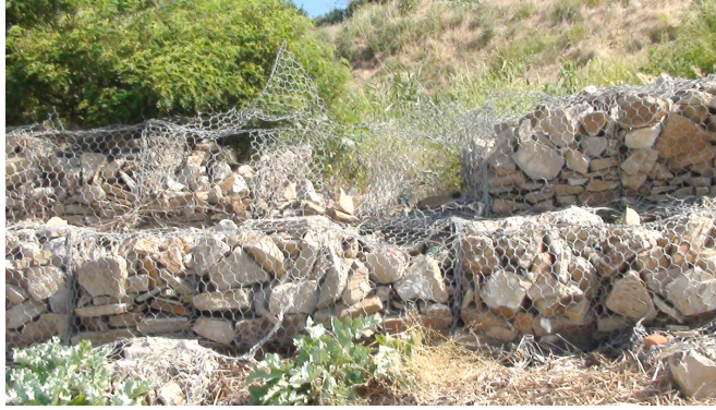
Берегозащитное сооружение Пушкинская набережная (нереконструированная часть)
