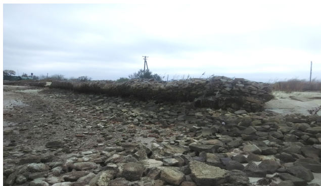
Рис. 50. Берегозащитное сооружение (х. Чумбур-Коса Азовского района).
