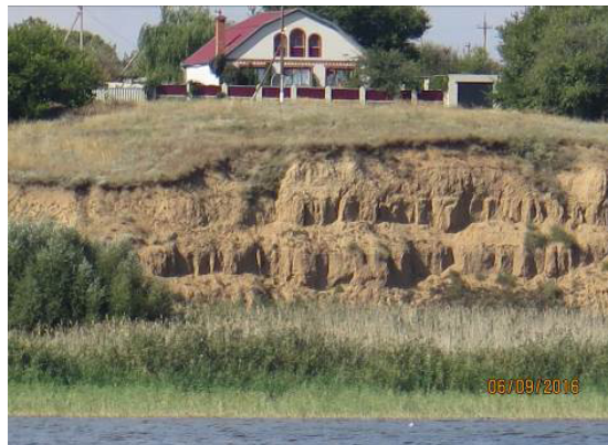
Рис 29. Обрушение коренного берега в ст.Суворовской
