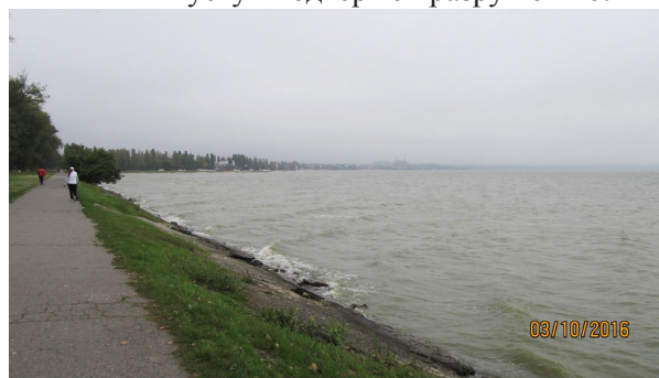
Берегозащитное сооружение х. Чумбур-Коса в Азовском районе
