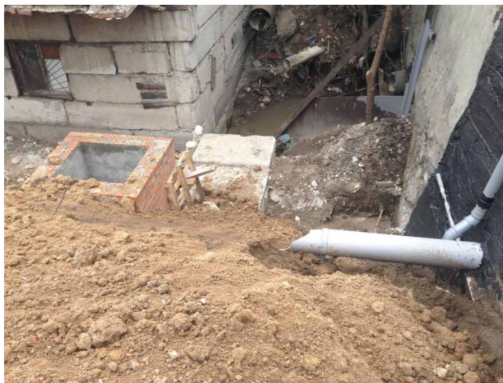
Фото гидротехническое сооружение на водном объекте б. Безымянная
