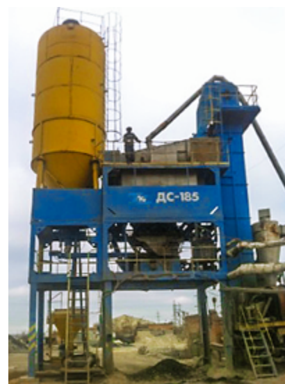
Источник выбросов загрязняющих веществ в атмосферный воздух ООО «ДРСУ «Автодор» асфальтомесительная установка ДС-185
